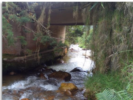
Imagen 4. PMDC RO-O2. Fuente CDMB.
